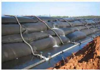
Геотубы – это объемные цилиндрические системы из высокопрочного геотекстиля, устойчивого к биологическому и химическому воздействию щелочей и кислот. По технологии производства можно выделить «сшивные» и «бесшовные» геотубы.
