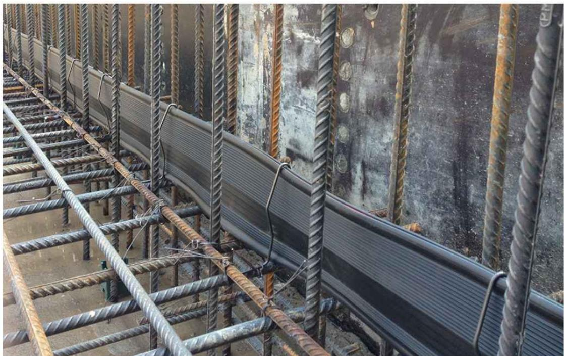
Монтаж композитной гидрошпонки (с вставками бентонитового шнура) для обустройства технологического шва бетонирования сопряжения вертикальной ж/б стены и плиты
