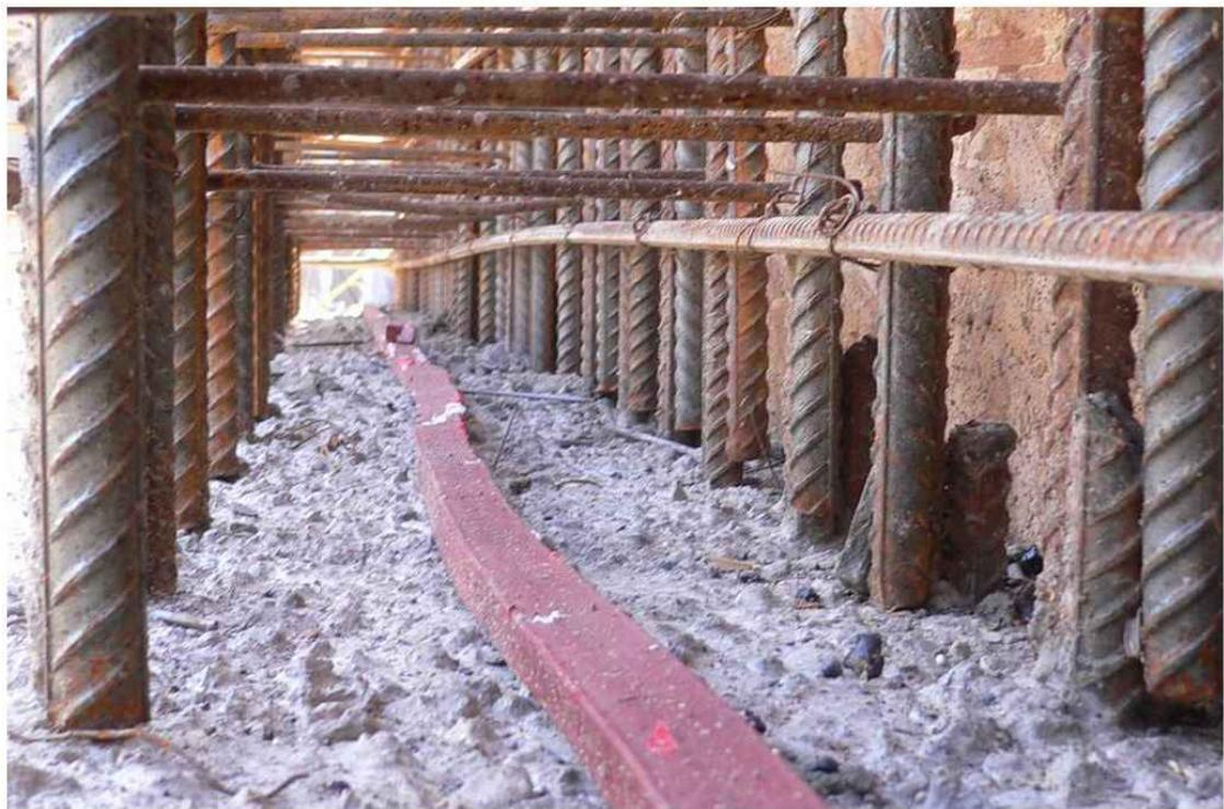
Монтаж бентонита Гидрофест, при устройстве стыка плиты фундамента и вертикальной ж/б стены
